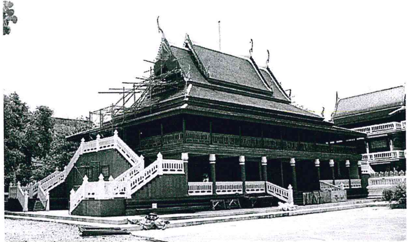
ศาลาการเปรียญวัดแก้วไพฑูรย์ เดิมเป็นเรือนไทยใต้ถุนสูง แต่ถูกน้ำท่วมบ่อย ทางวัดจึงถมดินจนมีระดับเสมอกับพื้นของศาลาการเปรียญ จึงยกตัวอาคารให้สูงขึ้นมีระเบียงรอบศาลาการเปรียญ มีห้องชั้นล่างเพิ่มประโยชน์ใช้สอย เริ่มบูรณะเมื่อพฤษภาคม พ.ศ. 2555 คาดว่าจะเสร็จราวพฤษภาคม พ.ศ. 2558
